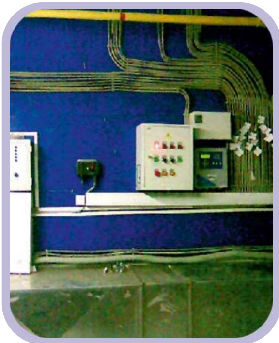
Монтаж кабельной разводки и пультов управления/Внутренний газопровод к ОВУ (желтые трубы).
