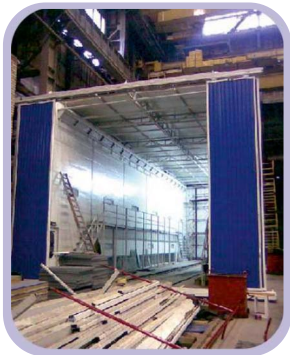
Монтаж раскатных ворот и галерей.
