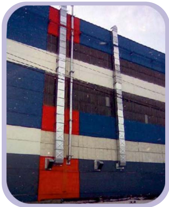
Внешние воздуховоды и дымоходы от двух ОВУ.
