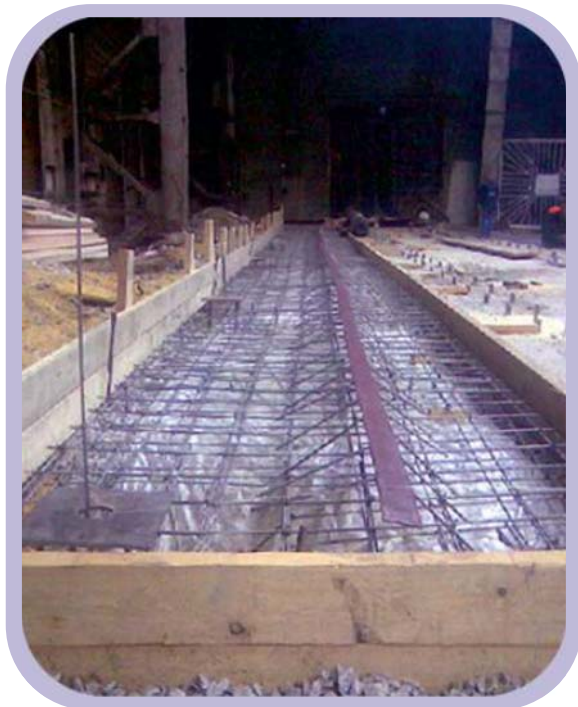
Армирование и установка закладных.
