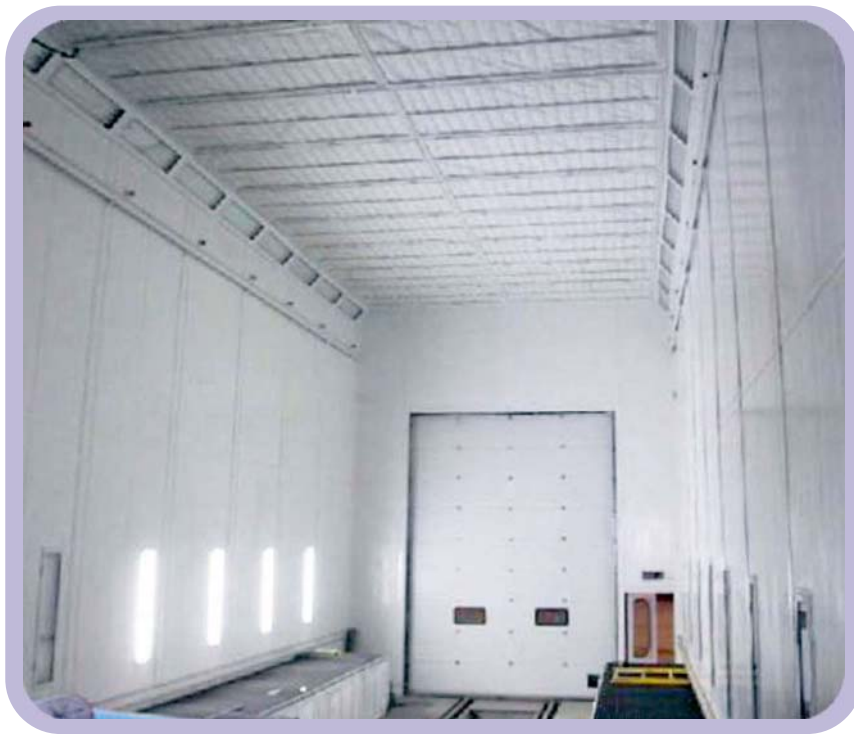
Секционные ворота «DoorHan» на «Окрасочно-сушильной» камере для электровозов на «Уральские локомотивы» г. Верхняя Пышма Свердловской области
