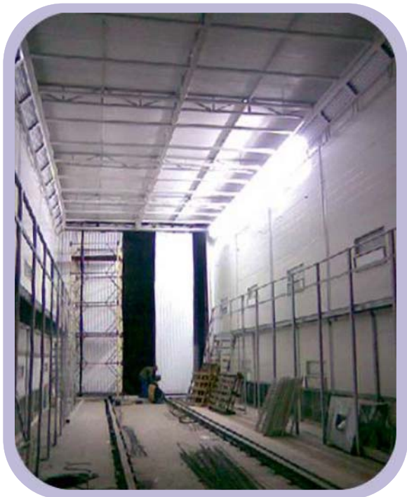
Монтаж рельсового пути и металлокаркаса.
