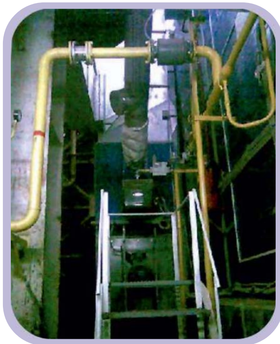
Монтаж кабельной разводки и пультов управления/Внутренний газопровод к ОВУ (желтые трубы).
